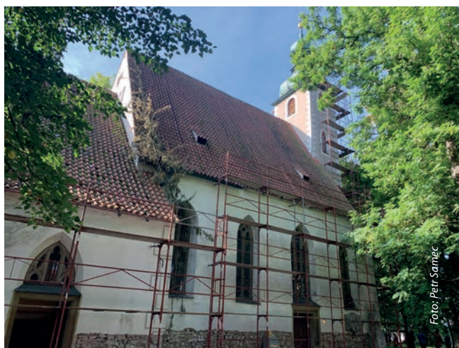
Práce na opravě kostela byly zahájeny 12. srpna 2024.
